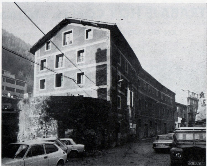
Monasterio de Santa Ana. Uno de los edificios condenado a desaparecer, en la villa de Placencia de Las Armas.
